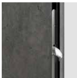
2 háky proti vylomení protipožární těsnění (Typ II)
